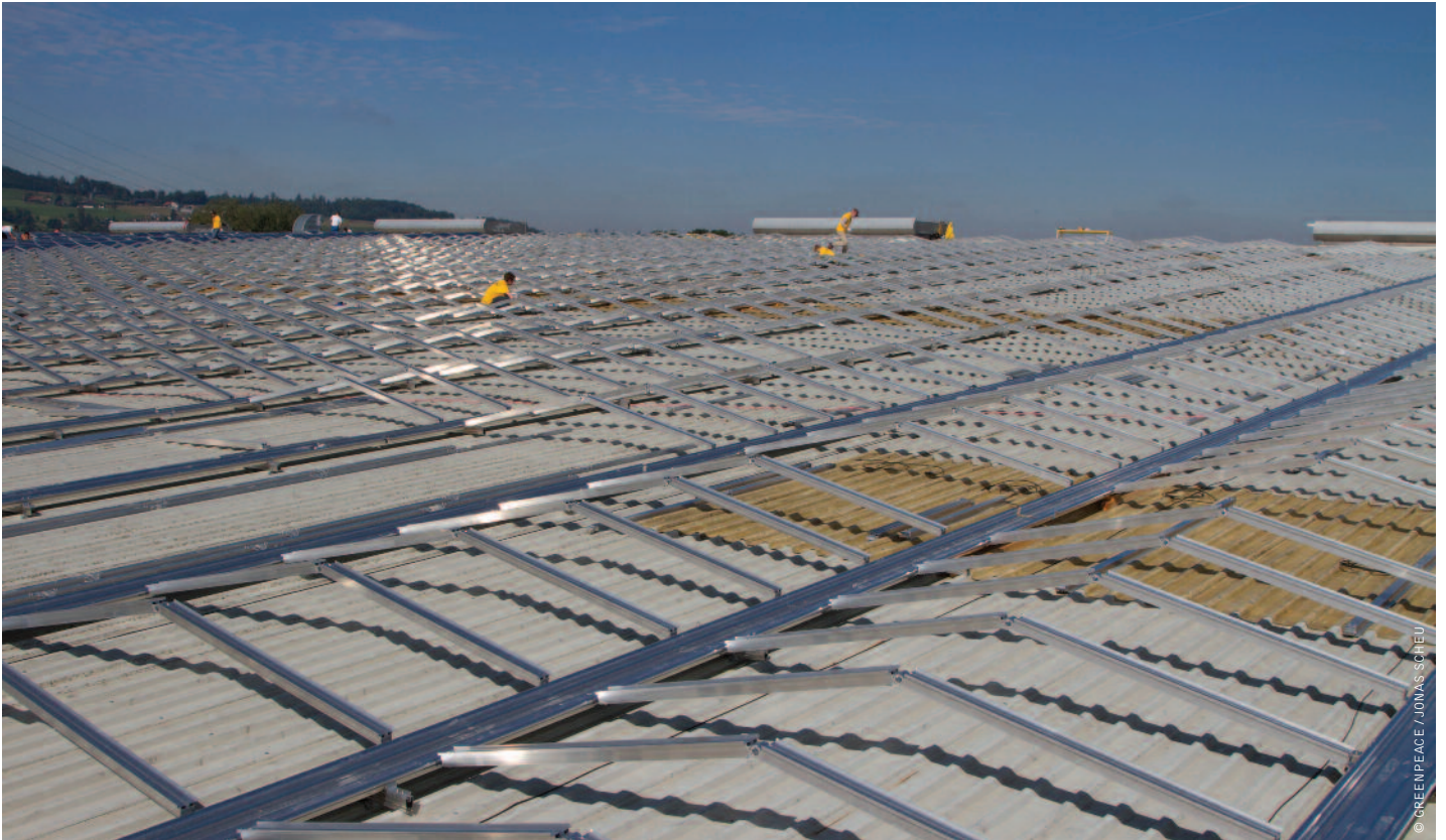
bild MONTAGE DER DAMALS GRÖSSTEN PHOTOVOLTAIK AUF-DACH-ANLAGE IN WOHLER AG MIT FREIWILLIGEN VON GREENPEACE.
