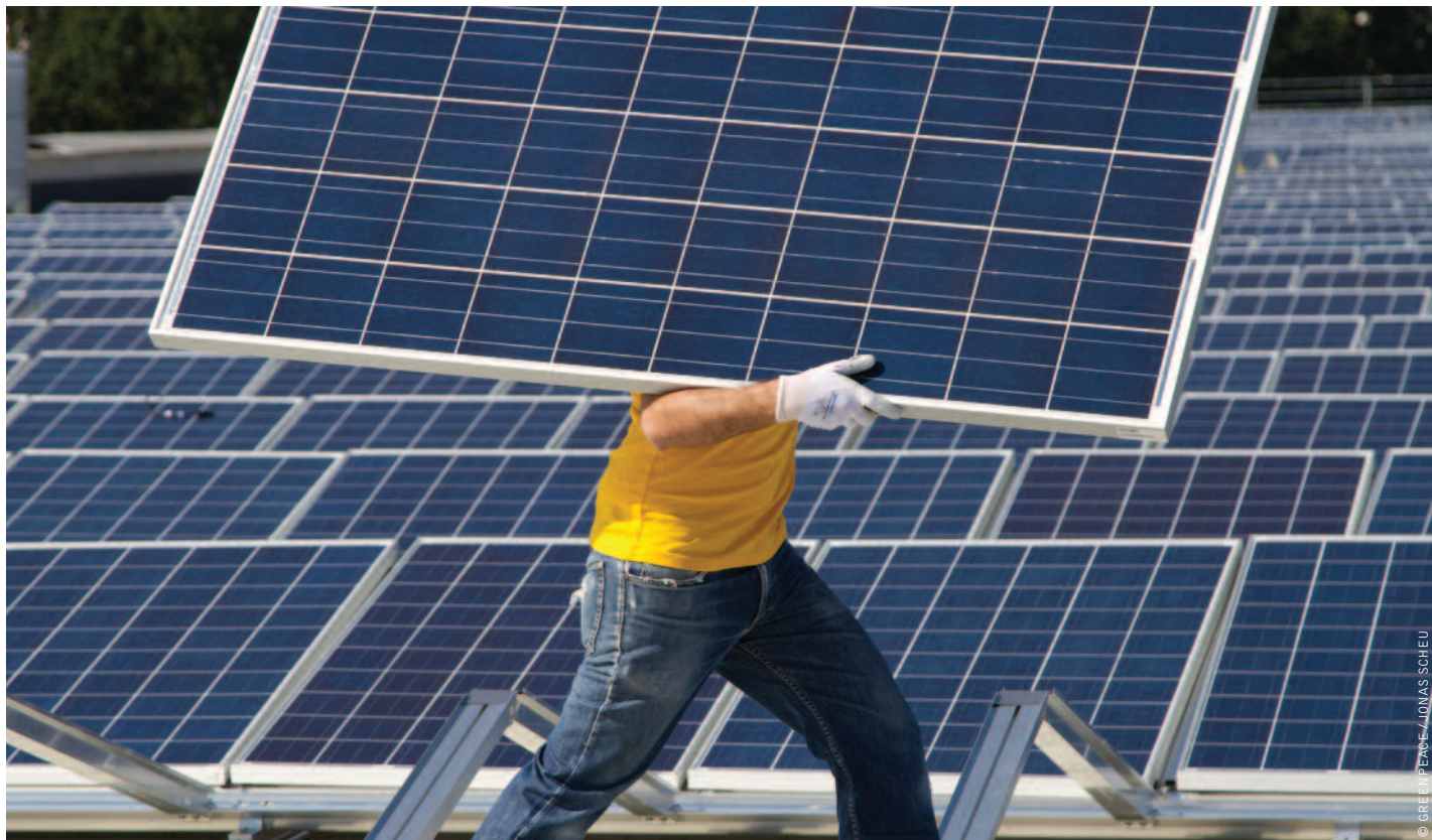
bild MONTAGE DER DAMALS GRÖSSTEN PHOTOVOLTAIK AUF-DACH-ABLAGE IN WOHLER AG MIT FREIWILLIGEN VON GREENPEACE.
