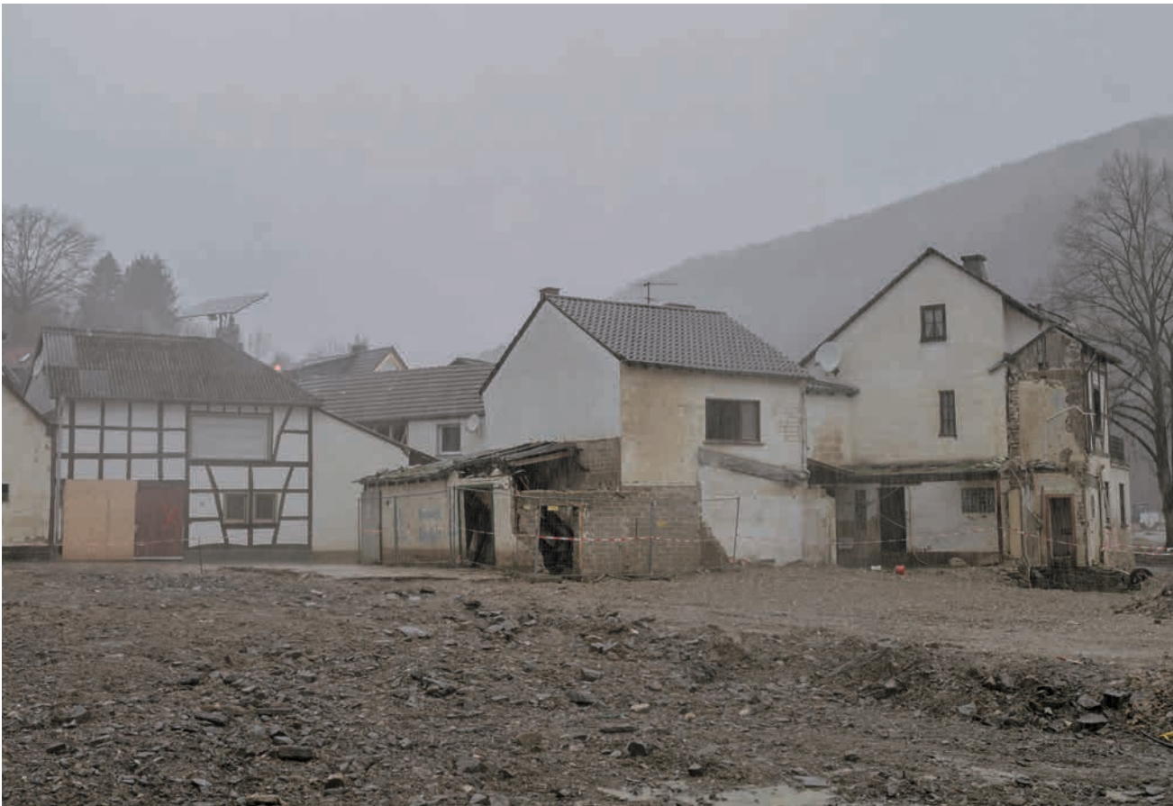
La vallée de l'Ahr en février 2022. Sept mois après les crues, de nombreuses maisons restent inhabitables et la région ressemble à un champ de ruines.
