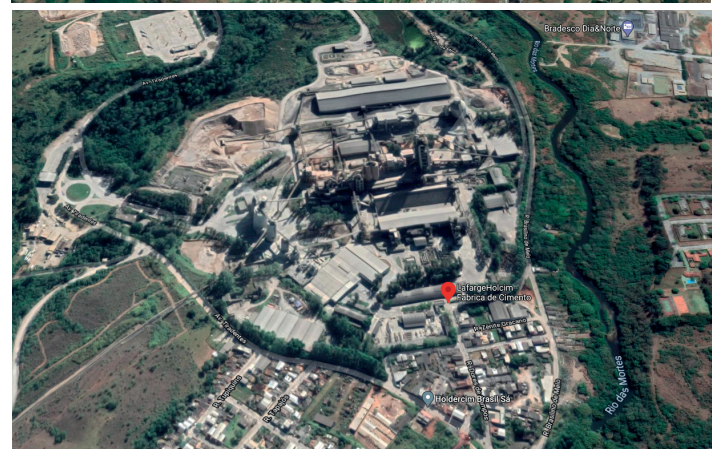
Die Zementfabrik der LafargeHolcim -Tochter LafargeHolcim (Brasil) S.A. in Barroso, Minas Gerais, Brasilien 68 .
