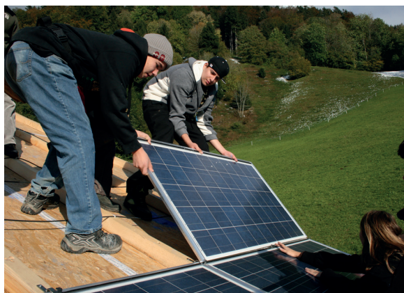
Im Rahmen des JugendSolarProjekts montieren Jugendliche eine 550 Quadratmeter grosse Photovoltaik-Anlage auf dem Dach eines Bauernhofs in Oberdorf, Schwyz. © Greenpeace
