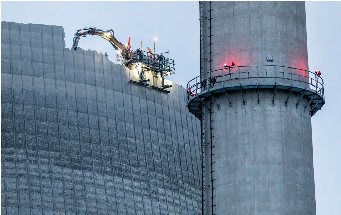
Démolition de la tour de refroidissement de la centrale nucléaire désaffectée de la compagnie RWE à Mülheim-Kärlich, sous la surveillance des ouvriers.
