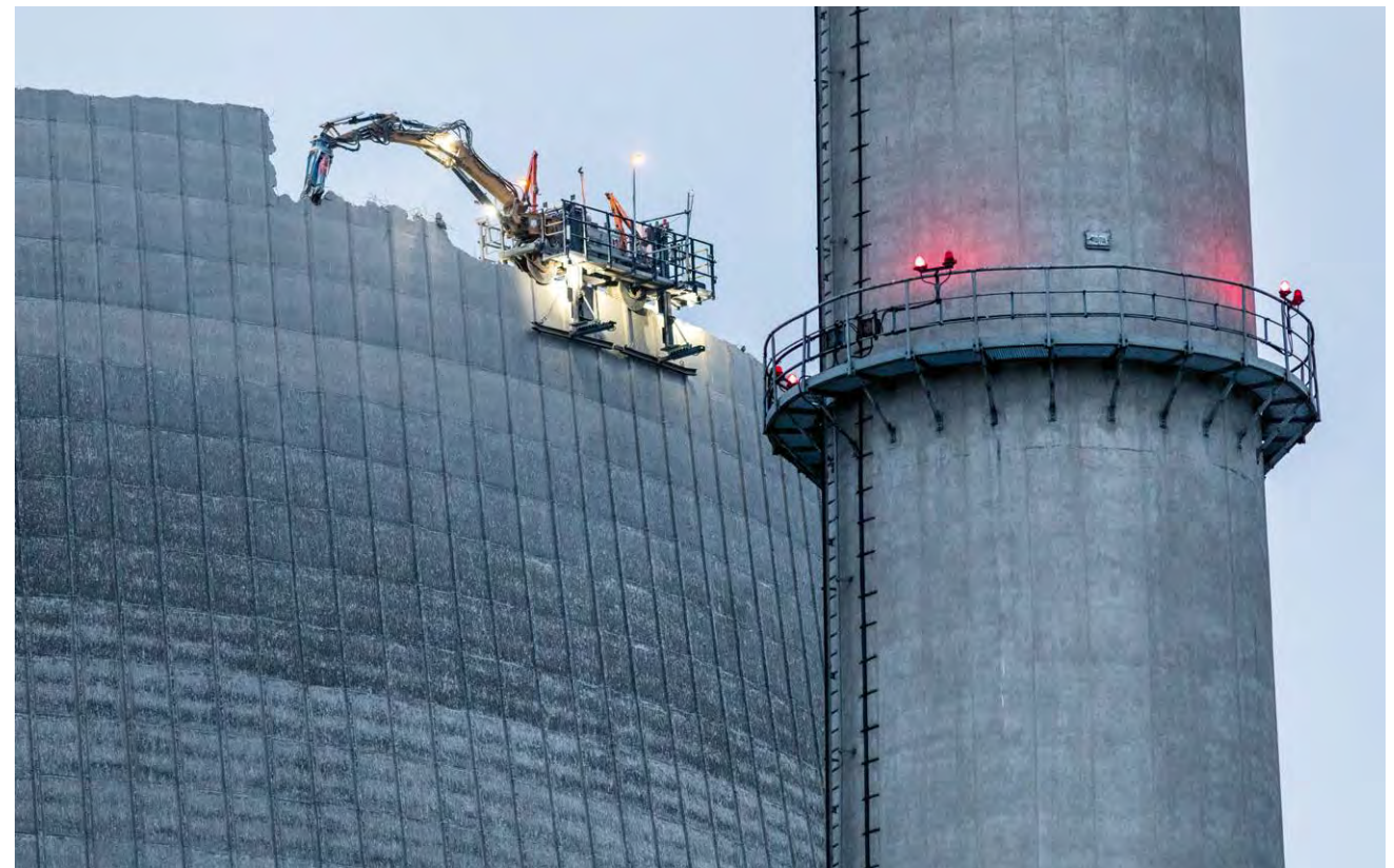
Der Kühlturm des stillgelegten Atomkraftwerks Mülheim-Kärlich wird mit einem Spezialgerät abgerissen, das von Arbeiter:innen auf dem Turm überwacht wird.
