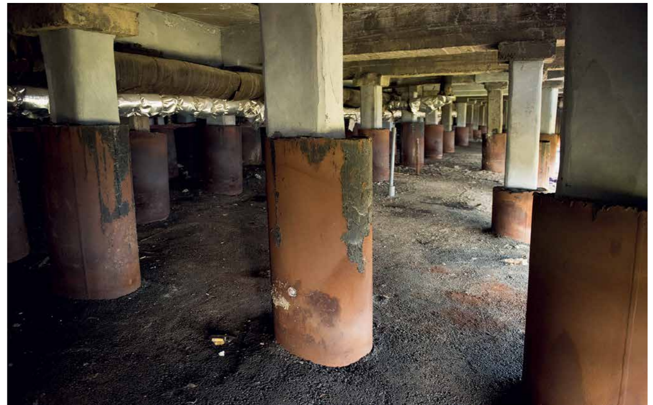
In ganz Sibirien tauen wegen der Klimaerhitzung die Permafrostböden tiefer als bisher auf. Viele Gebäude auf Stützen, die in den gefrorenen Boden gerammt sind, sacken deshalb ab.
